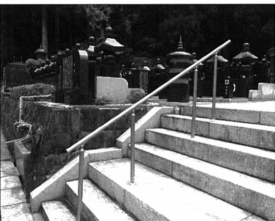
大変お待たせいたしました。前々からご要望の多かった、宝塔入口の階段に手すりを取り付けました。
